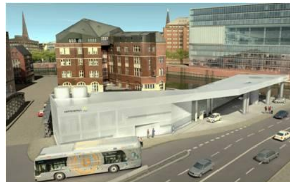
Vattenfall, Hafen City Hamburg, Germany, 2014
